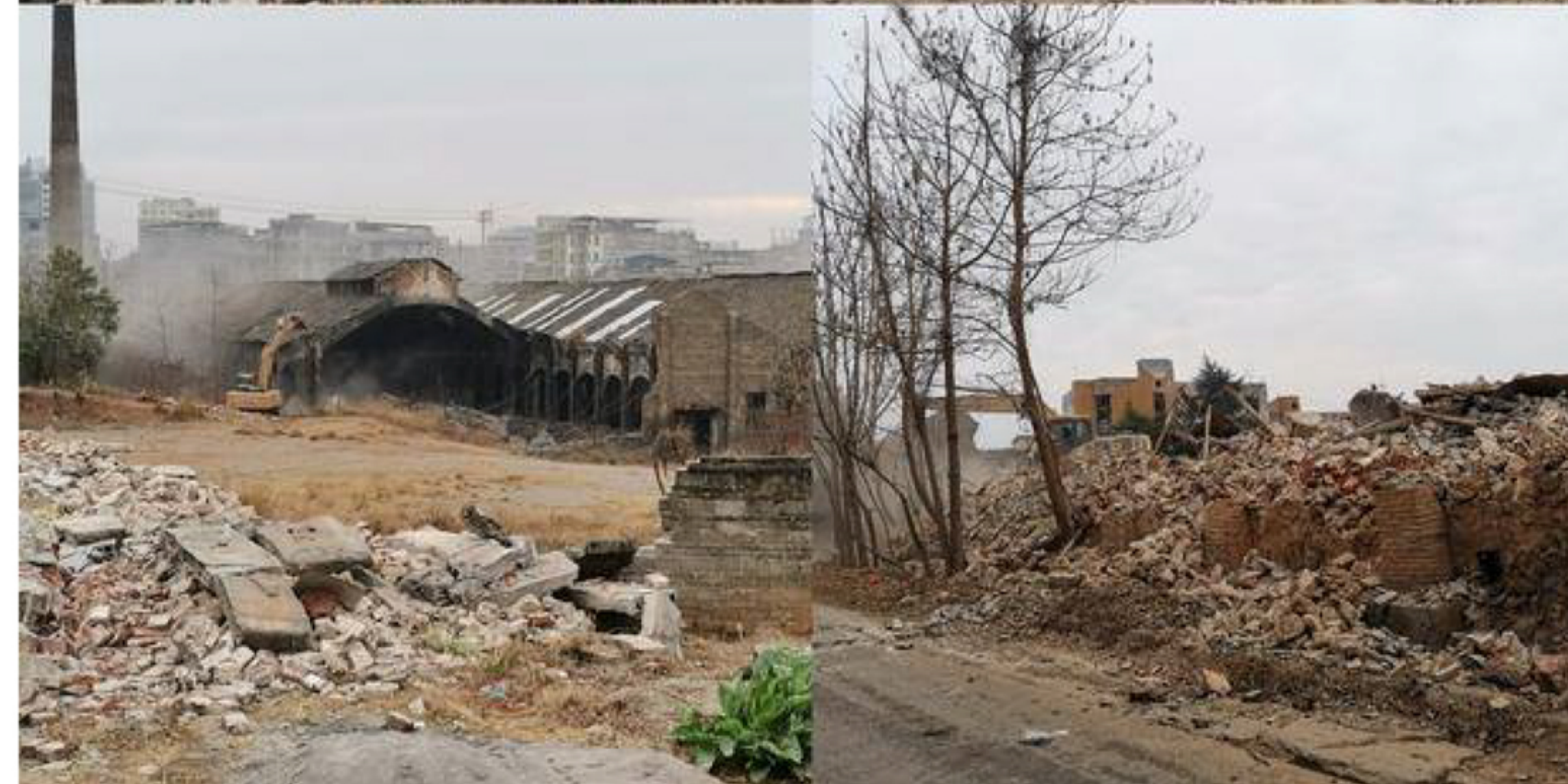
*瓷厂厂房拆除现场
